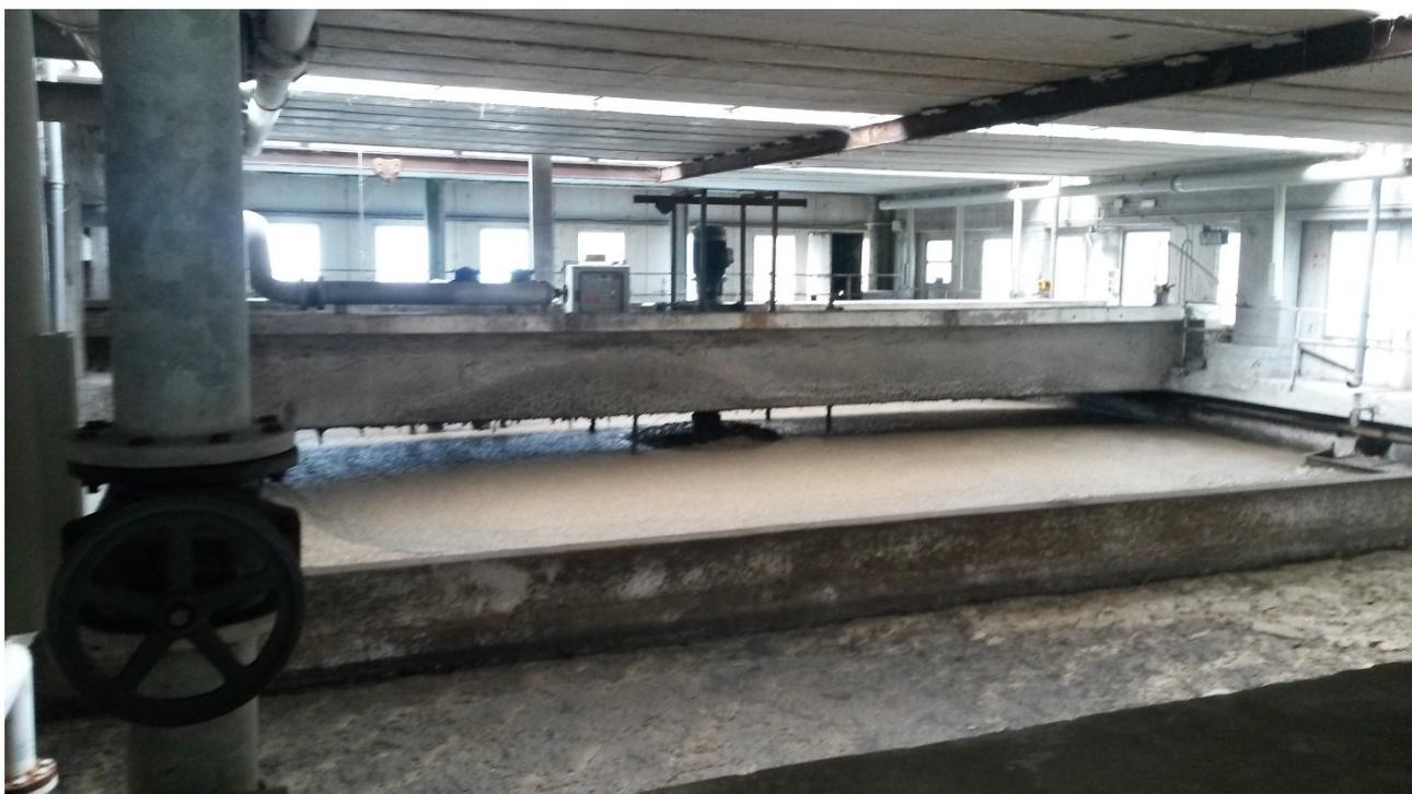
Foto 9: Interno del fabbricato di contenimento delle vasche di ossidazione biologica
